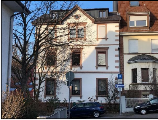
Abb.31: Horizontale und vertikale Gliederung bei einem traufständigen Gebäude in der Hildastraße
