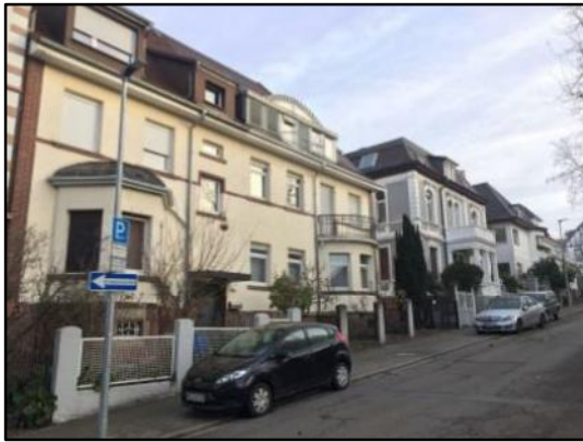
Abb.15: Gebäude mit Auslucht in der Moltkestraße
