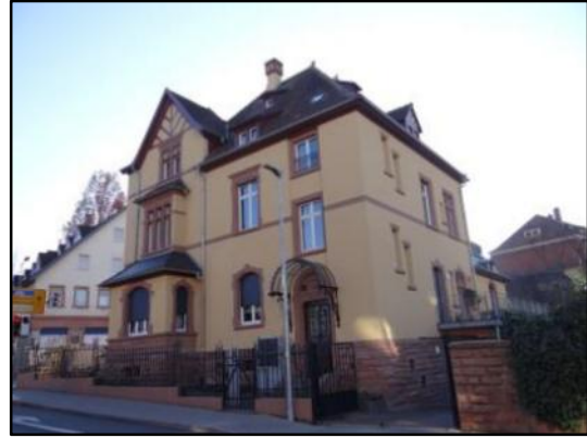
Abb. 37: Sockel, Faschen und Gesims aus Naturstein
