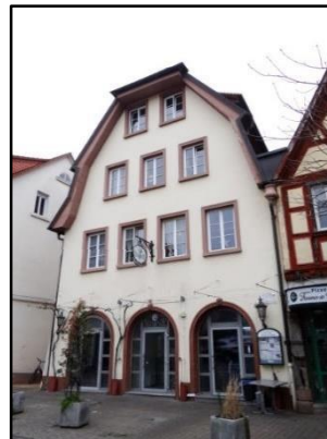
Abb. 8: Giebelständige Gebäude in der Hauptstraße
