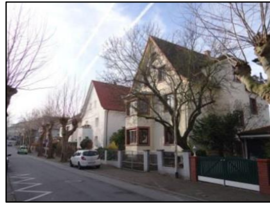
Abb. 13: Ausbau des dritten Geschosses als Vollgeschoss in der Albert-Ludwig-Grimm-Straße
