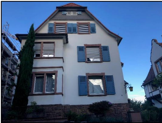
Abb. 32: Horizontale und vertikale Gliederung bei einem giebelständigen Gebäude in der Ehretstraße
