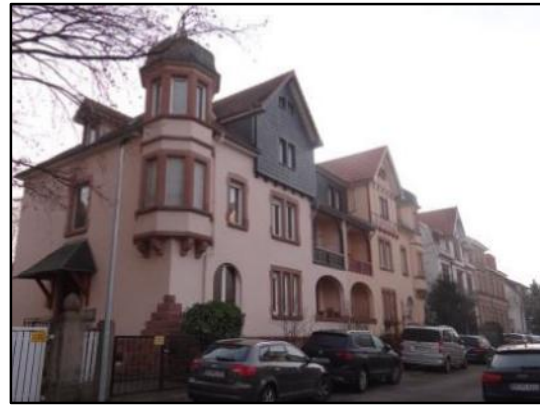
Abb.16: Gebäude mit Runderker in der Hildastraße
