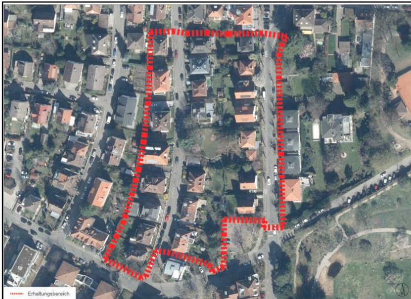
Abb. 19: Farbgebung der Dachlandschaft im Erhaltungsbereich
