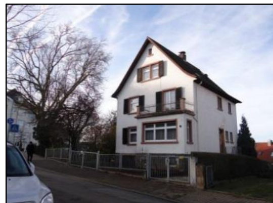
Abb. 8: Giebelständiges Gebäude in der Albert-Ludwig-Grimm-Straße
