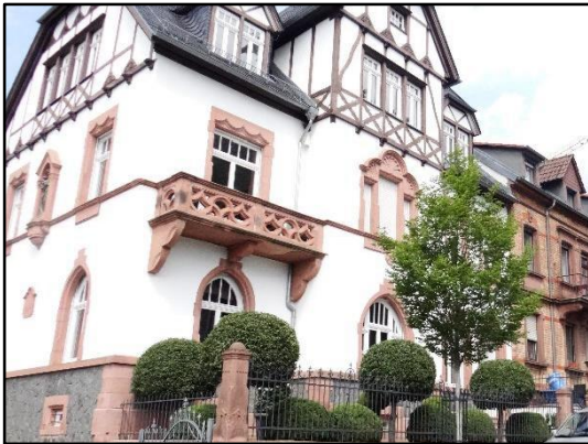
Abb. 38: Gebäude mit Sockel- und Fensterbankgesims
