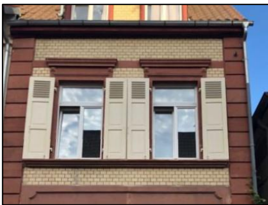
Abb. 27 und 28: Fensterläden im Erhaltungsbereich
