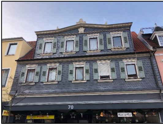
Abb. 26: Typische Fensterformate im Erhaltungsbereich
