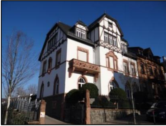
Abb. 40: Faschen und Gesims aus Buntsandstein
