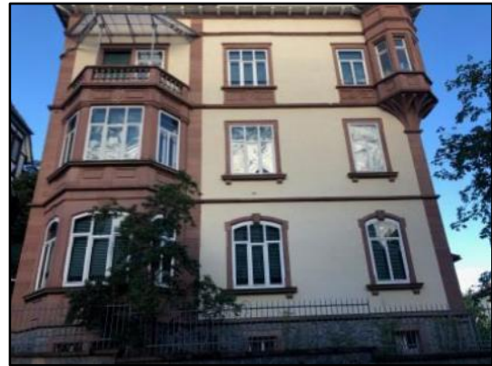
Abb.39: Gebäude mit Gurt- und Sockelgesims
