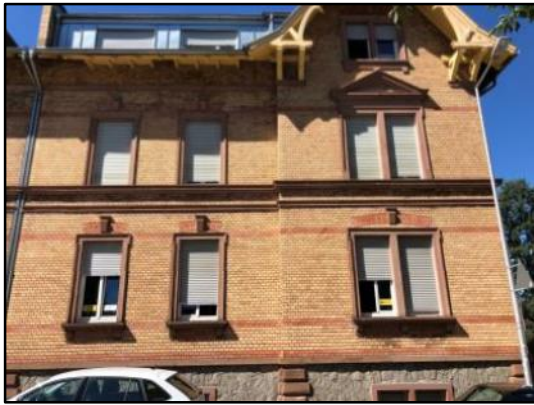
Abb. 39: Gebäude mit Sockel-, Gurt- und Fensterbankgesims
