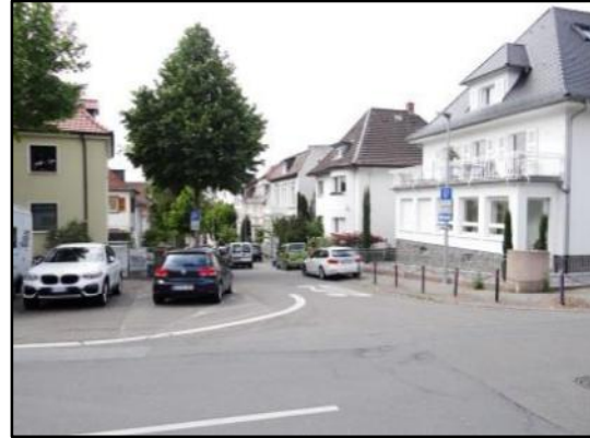
Abb.13: Bebauung entsprechend dem nach Westen abfallenden Ge
