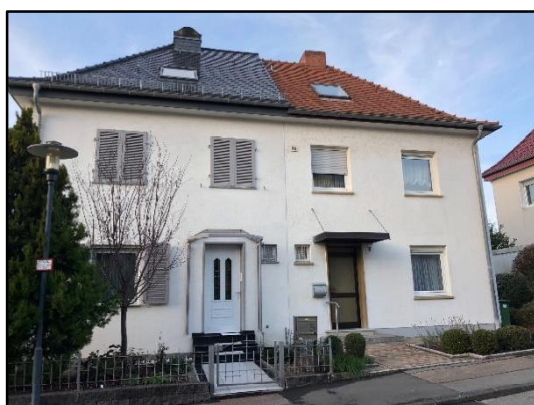
Abb. 7: Traufständige Gebäude in der Bodestraße
