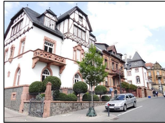
Abb. 10: Gebäude mit vorgegarterm Gartenbereich und Stützmauer
