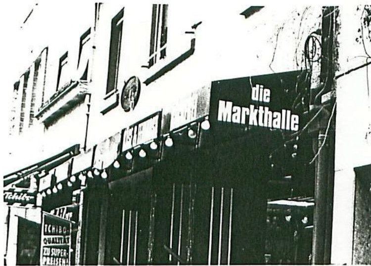
Beispiele für Schaufenster und Vordächer, die auf die Fassade abgestimmt sind. (Bereich C)
