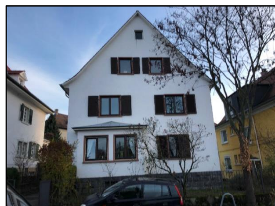
Abb. 8: Giebelständiges Gebäude in der Karrillonstraße
