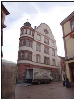
Abb. 29: Gebäude mit Gurt- und Fensterbankgesims
