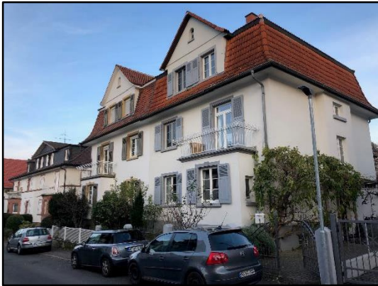
Abb. 12: Ausbau des Dachgeschosses in der Bissingerstraße
