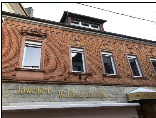
Abb. 25: Typische Fensterformate im Erhaltungsbereich
