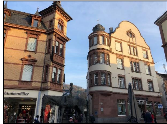
Abb. 14: Gebäude, die auf Grund ihrer Höhe nicht der typischen Bebauung im Erhaltungsbereich entsprechen
